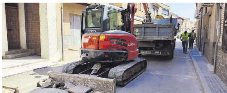
Obras de mejora en la accesibilidad y la red de abastecimiento en la calle Cruz de Aljucer.
