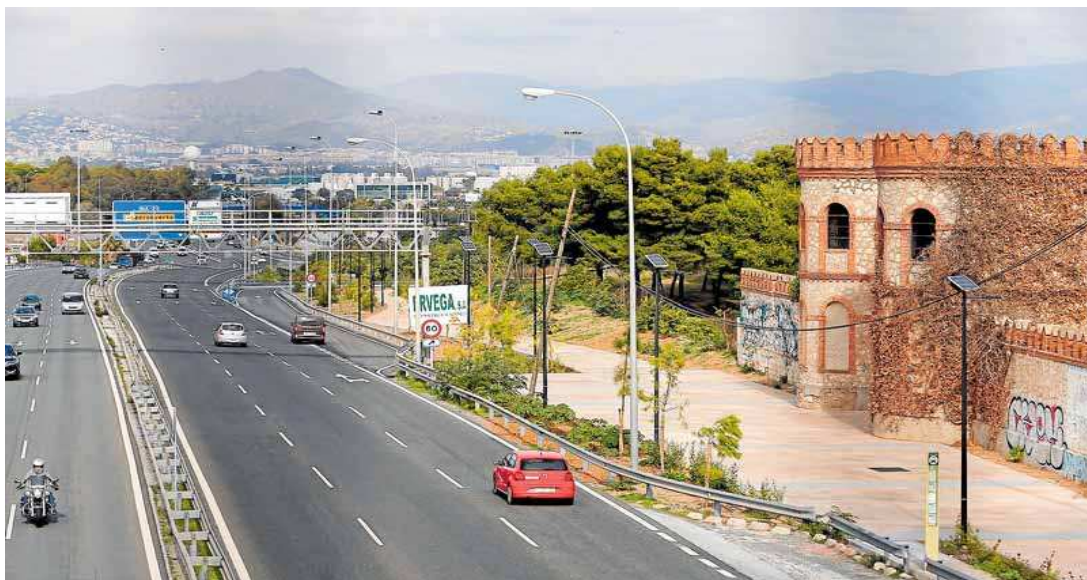
Vista del Campamento Benítez. SUR
