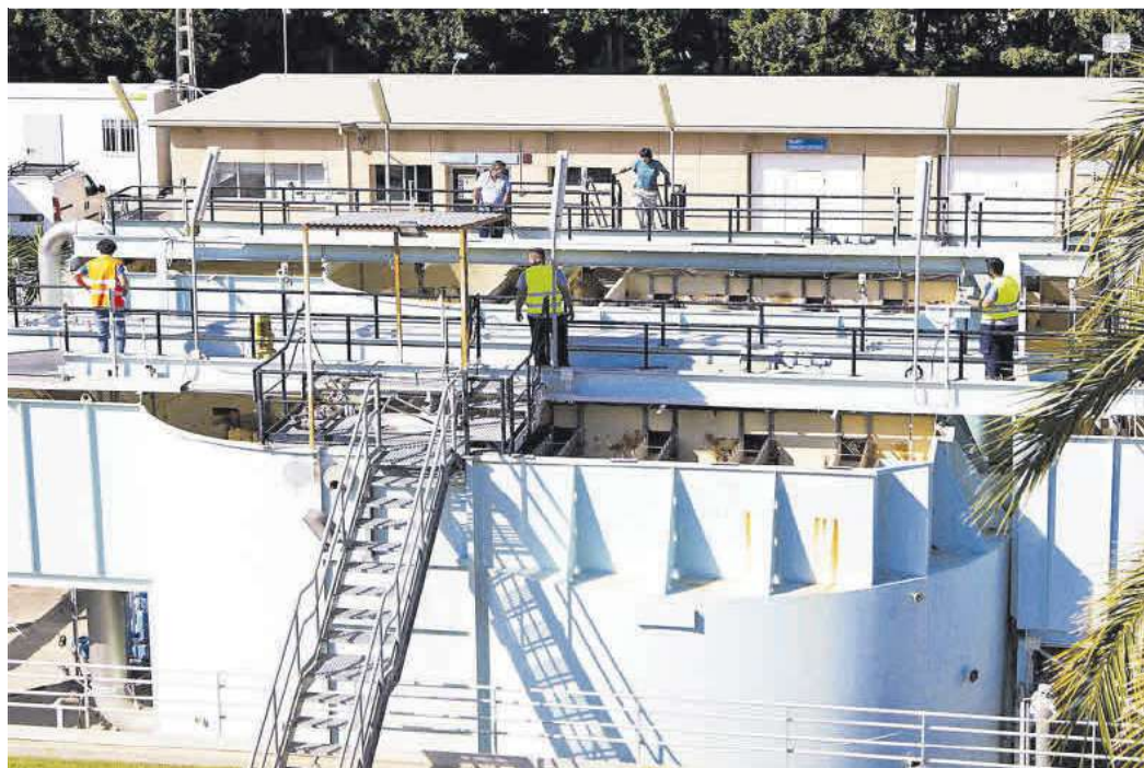
Instantánea de la Estación de Tratamiento de Agua Potable de Lorca, en plenas obras.
